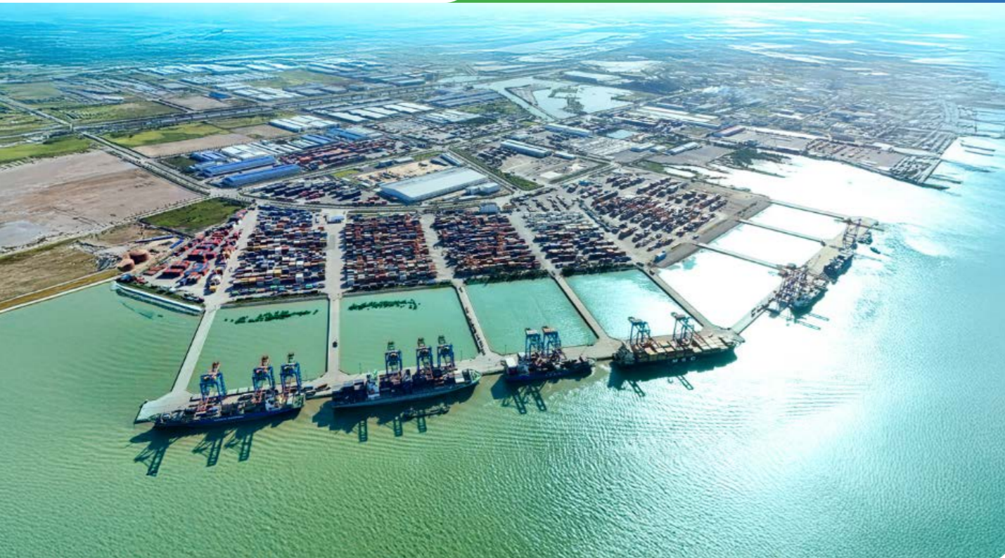
Cảng Nam Đình Vũ Giai Đoạn 3 chính thức được đưa vào hoạt động từ tháng 10/2025
