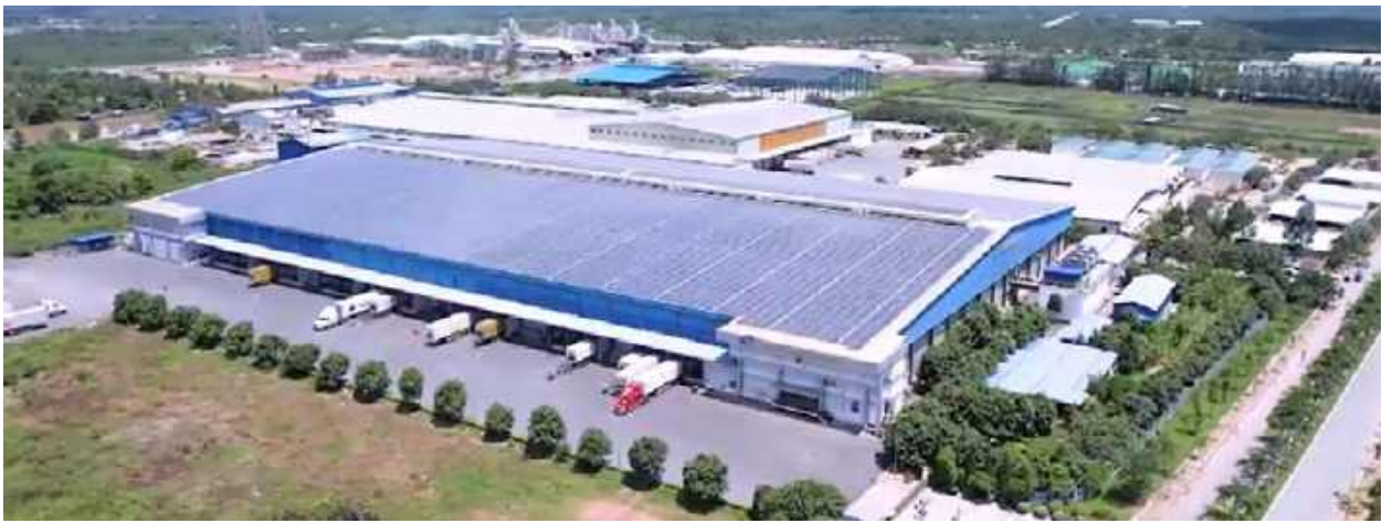
Điện mặt trời áp mái tại kho Mekong Logistics cung cấp sản lượng điện lớn cho vận hành từ năng lượng mặt trời
