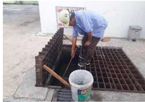
Vệ sinh, nạo vét rãnh nước, hố ga thu nước
