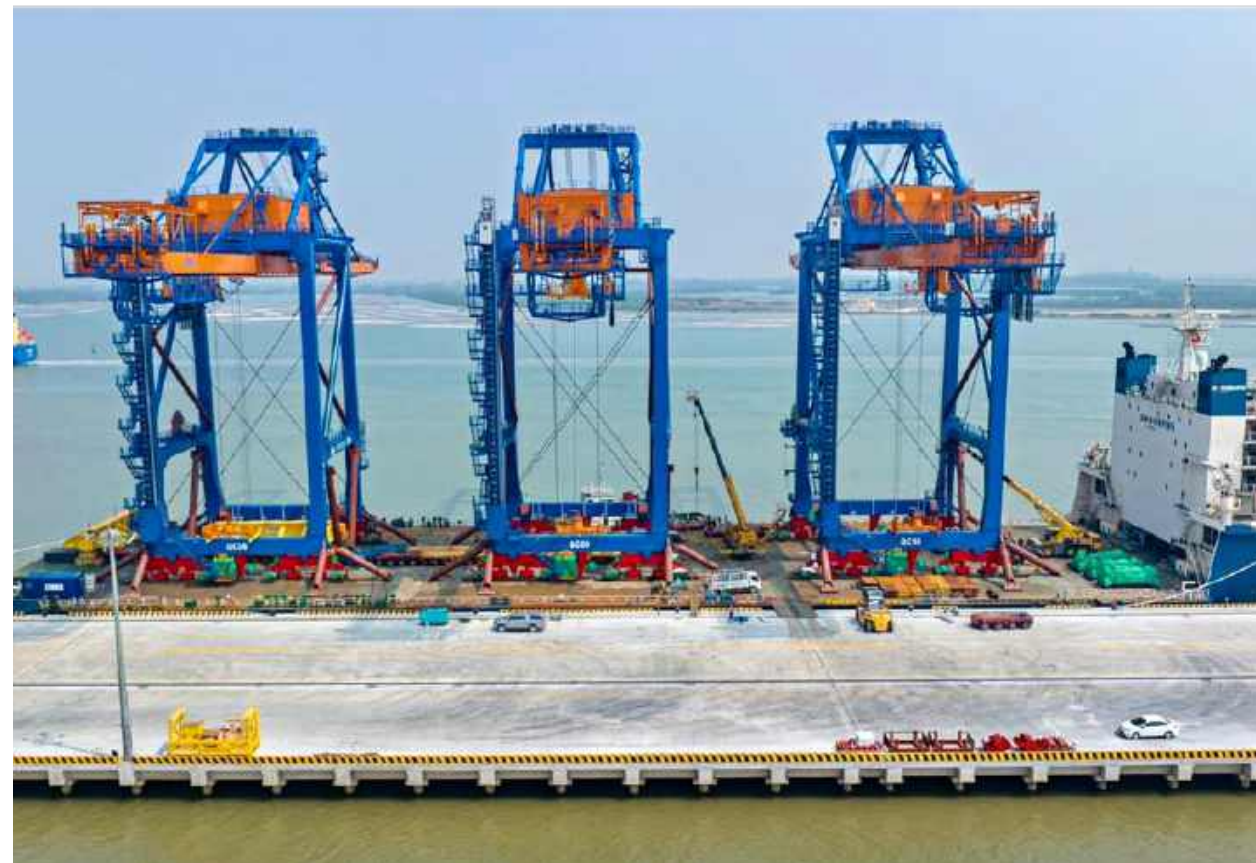
Cầu bờ STS 100% chạy điện đang được lắp đặt tại Giai đoạn 2 cảng Nam Đình Vũ
