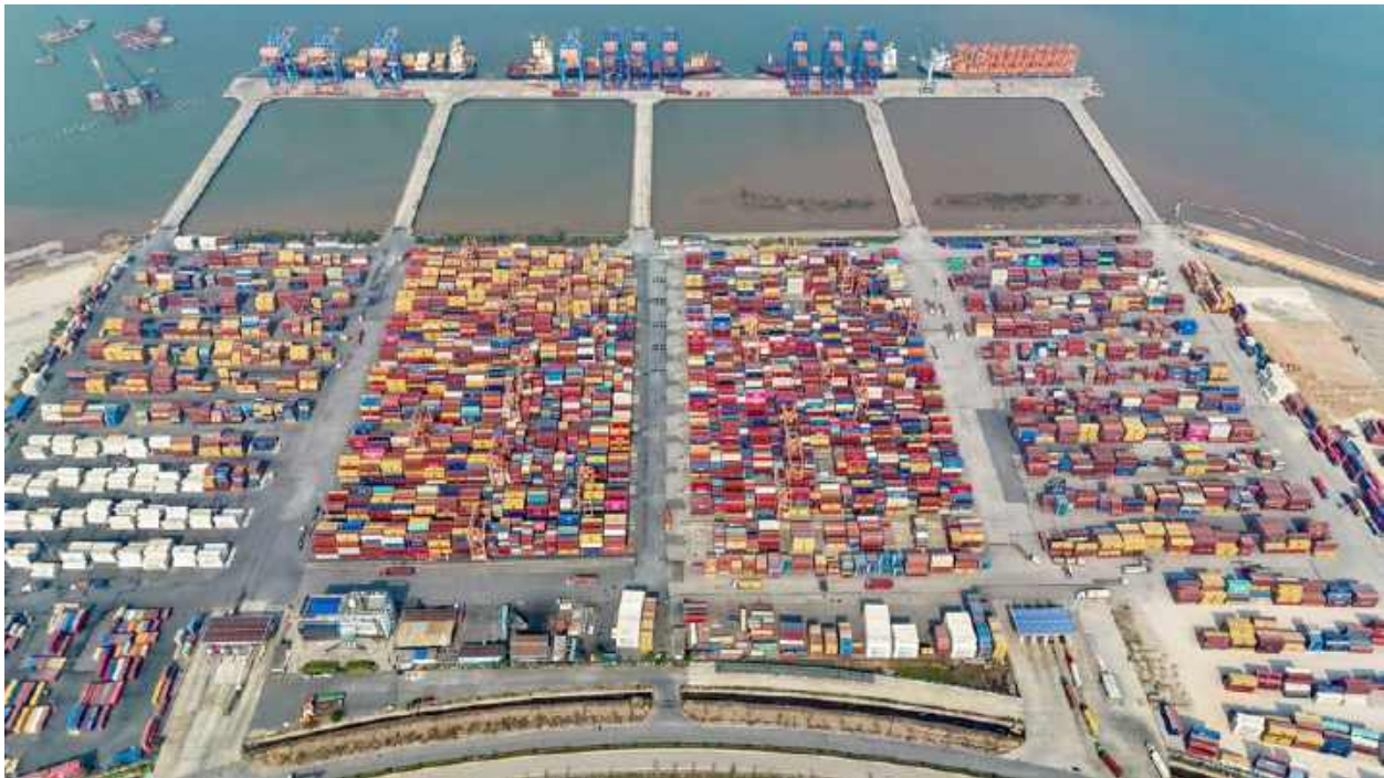
Tất cả thiết bị cầu STS và RTG của Cảng Nam Đình Vũ đều chạy điện 100%
