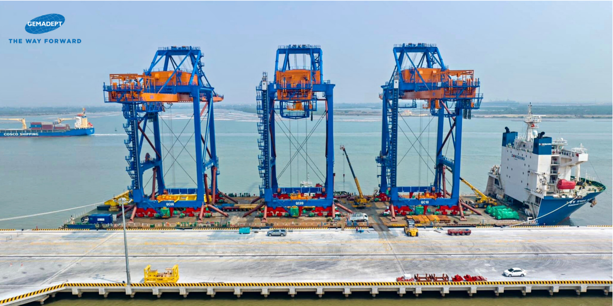
Cầu bờ STS 100% chạy điện đang được lắp đặt tại Giai đoạn 2 cảng Nam Đình Vũ
