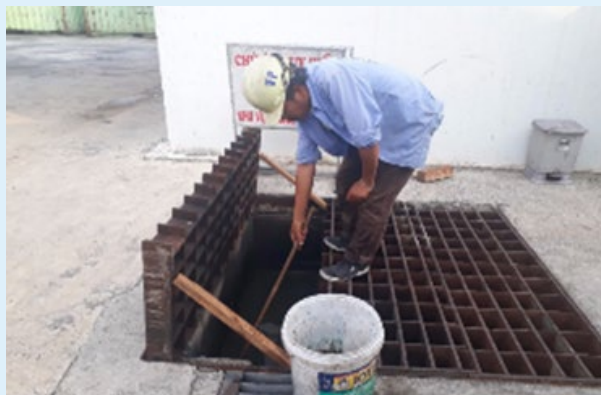
Vệ sinh, nạo vét rãnh nước, hố ga thu nước
