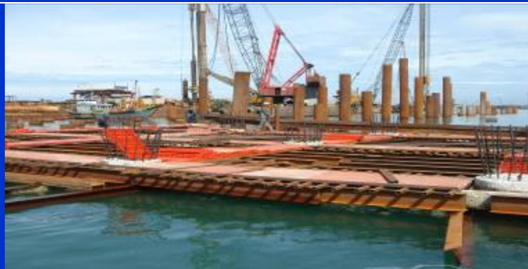
Công trường xây dựng
