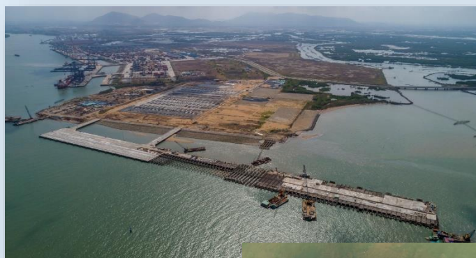
Toàn cảnh dự án Gemalink đang trong quá trình xây dựng
